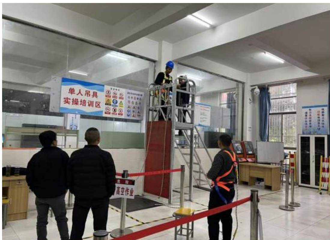
图 35 高处安装、维护与拆除作业培训现场
